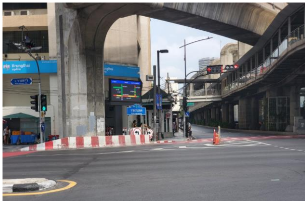
明顯的護欄及標線導引。
