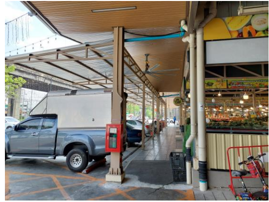
市場遮雨棚違建設施
