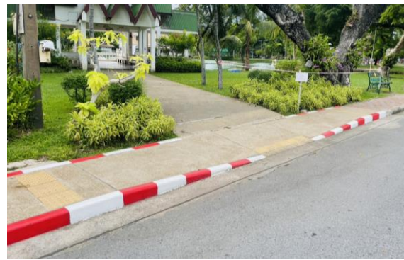
斜坡兩邊有明顯的標線。
