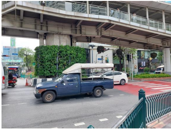
高架橋的落墩周圍用植栽包圍。
