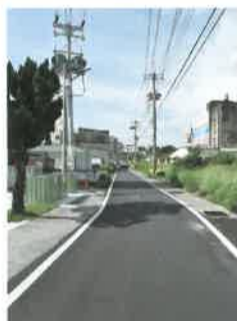
周邊道路重新整修
