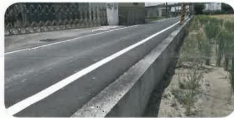
克東路擋土牆
