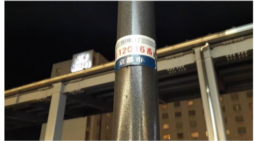
公共路燈設施-路燈名牌
