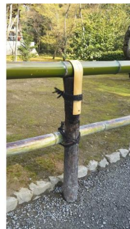
竹子欄杆及砌石路堤
