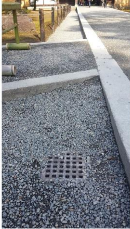
清碎石鋪面步道及清碎石排水溝
