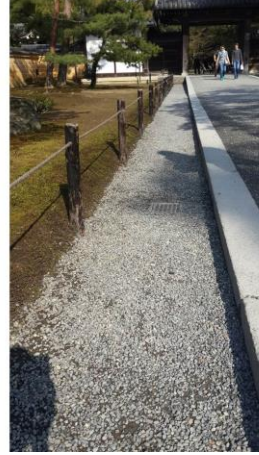
清碎石鋪面步道及清碎石排水溝
