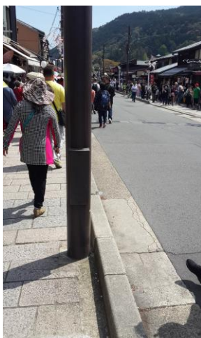
路燈基座以埋入方式設置
