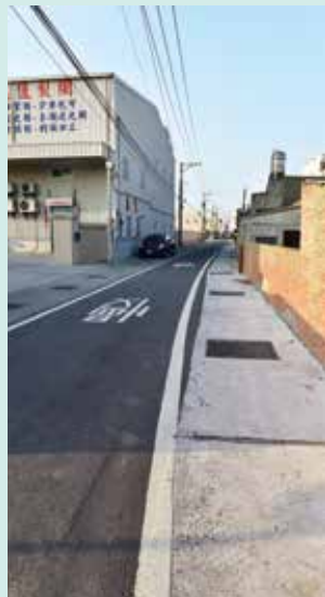
▲ 龍崙地水溝改善工程
