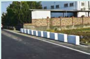
▲ 十茂路313巷擋土牆工程
