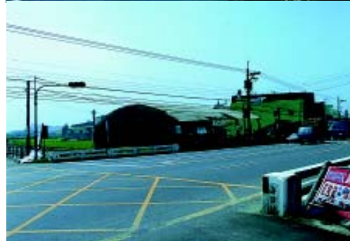
(上)中彰大橋(下)海尾橋
